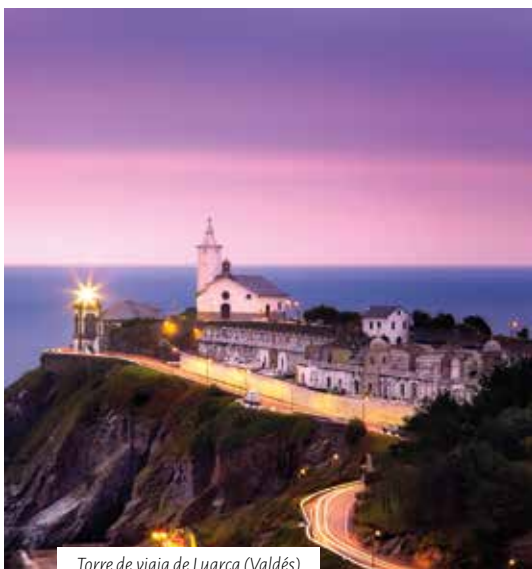
Torre de vigia de Luarca (Valdés)
